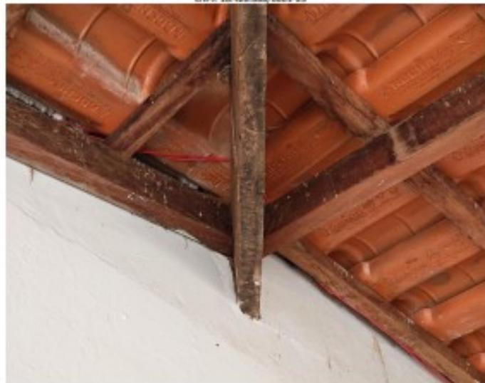
*Foto 03 – Seção da vigota com espessura insuficiente.*
