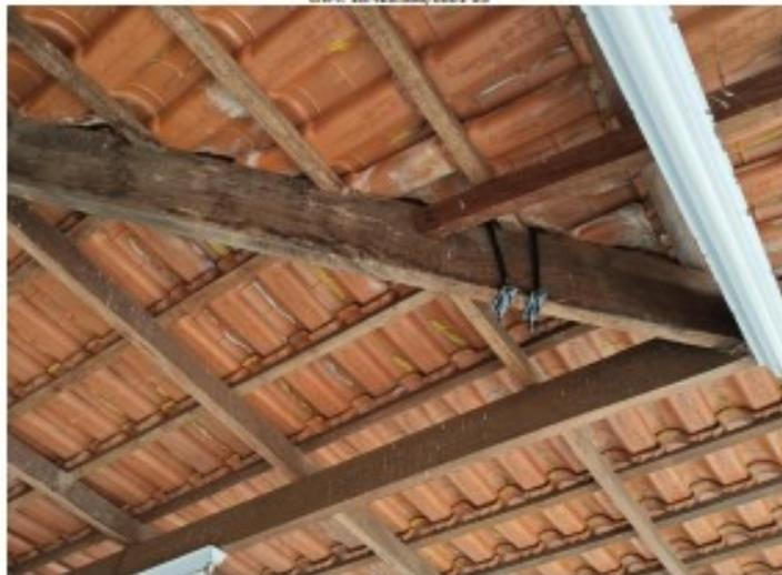
*Foto 02 – vista ampla do madeiramento com aspecto deteriorado.*
